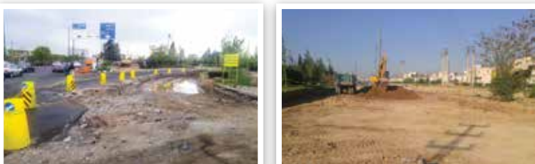
پروژه در حال ساخت زیرگذر فردیس استان البرز
