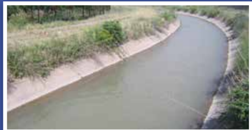
احداث کانال انتقال آب شرق کردان احداث سد انحرافی اعشمت
