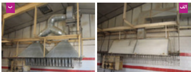
شکل ۱: تصویری از سیستم تهویه موضعی قبلی (الف) و فعلی (ب)
