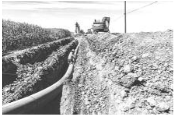
شکل ۱. شرکت Calgren از لوله کم فشار برای انتقال بیوگاز جمع آوری شده از گاوداری ها به مجتمع سوخت تجدیدپذیر استفاده می کند.
