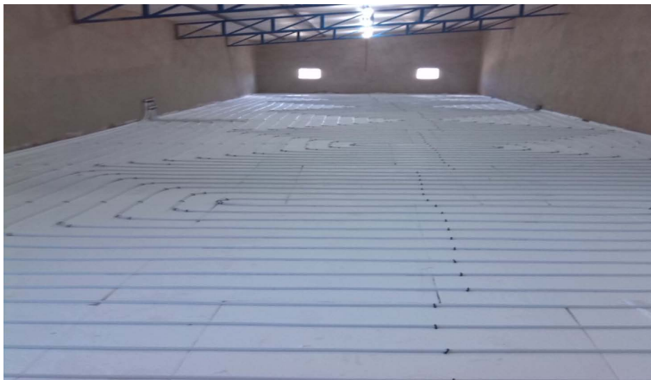
شکل ۷-۴- نحوه کارگذاری لوله‌های گرمایش از کف
