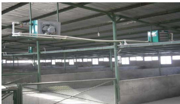
شکل ۶-۱۵- نمونه‌ای از سالن پرورش صفر تا یک ماهگی به همراه سیستم گرمایشی محیطی
